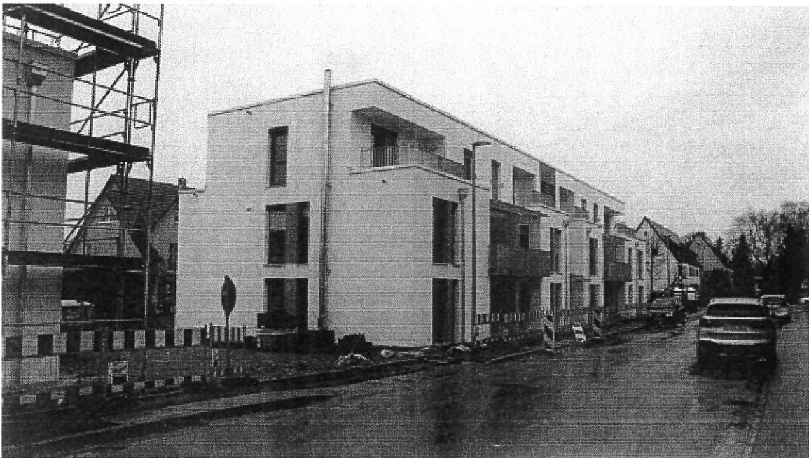
An der Wendelsteinstraße in Mering entstehen 23 Sozialwohnungen.
